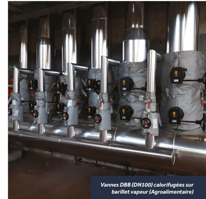
Vannes DBB (DN100) calorifugées sur barillet vapeur (Agroalimentaire)
